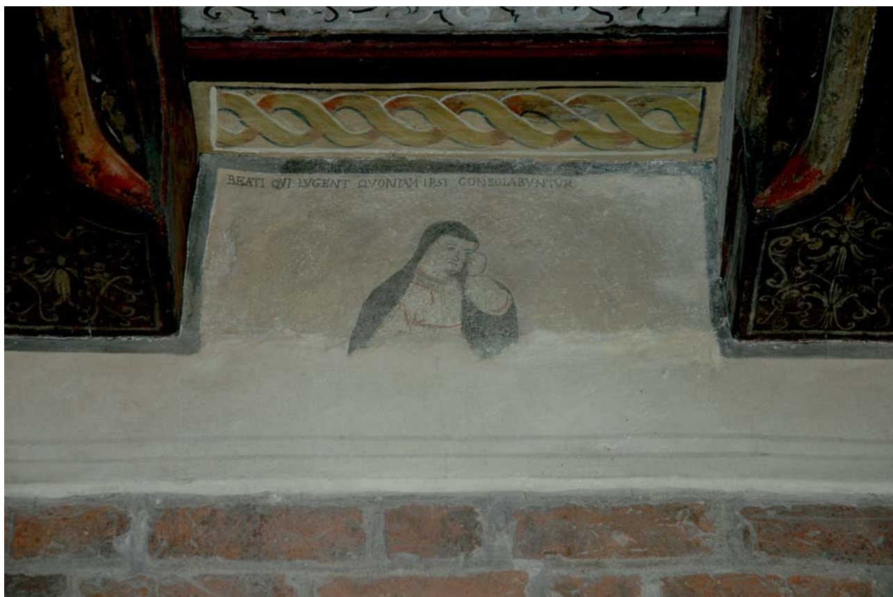
Ryc. 1. Malowidło znajdujące się pomiędzy belkami stropowymi, jedna z płytyn będąca częścią „Ósmiu Błogosławieństw”, pomieszczenie od strony Starego Rynku, ściana południowa
