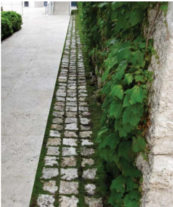
Fot. 2. Woda deszczowa kierowana jest w stronę nawierzchni pół-przepuszczalnej, skąd pobierana jest przez rosnące tam pnącza ( http://24.media.tumblr.com )
