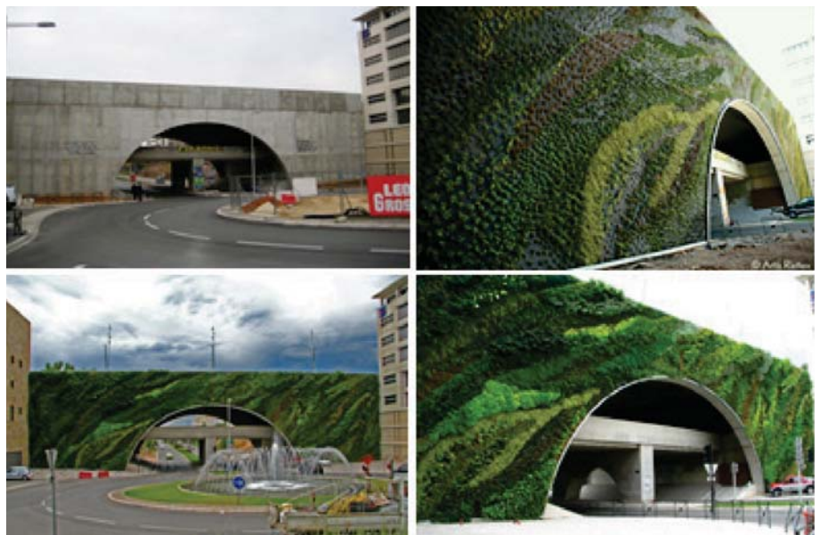
Fot. 4. Zielona ściana nad wjazdem do tunelu na różnych etapach budowy, 2008 r., proj. P. Blanc, Pont Max Juvenal, Aix-en-Provence, Francja [28]
