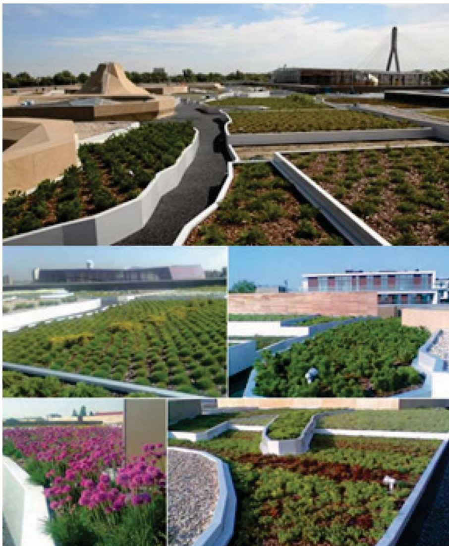
Fot. 1. Ekstensywny dach zielony o pow. 8000 m 2 na budynku Centrum Nauki Kopernik w Warszawie, 2010 r. ( www.optigruen.pl )
