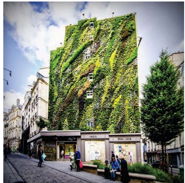
Fot. 3. Zielona ściana wykonana z roślin ozdobnych – traw, bylin, roślin okrywowych i niewielkich krzewów, Paryż, Francja ( www.epicgardening.com )
