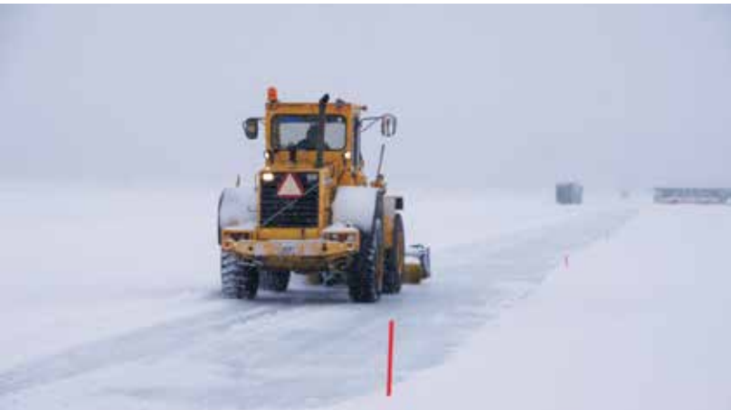
Ciężki sprzęt podczas przygotowywania toru prób z nawierzchnią o zmiennej przyczepności
