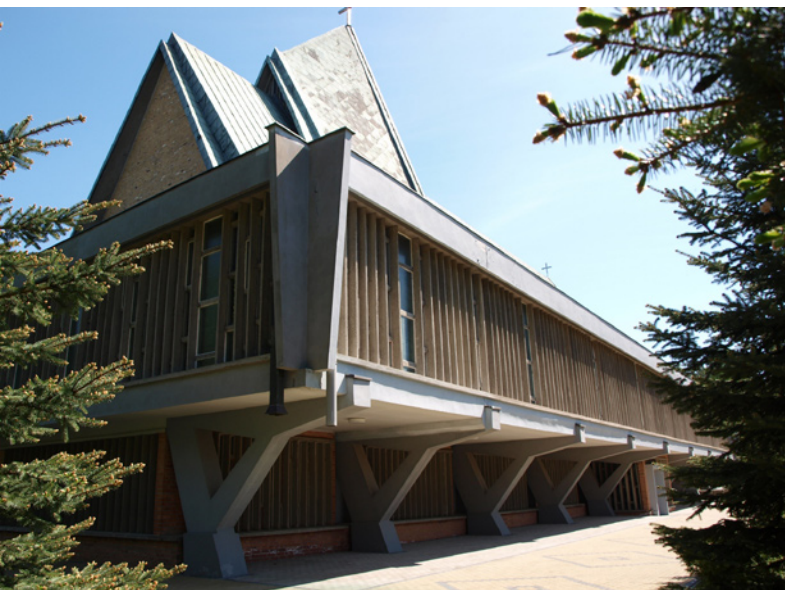
Ryc. 11. Kościół NMP Matki Kościoła w Sulejówku – elewacja boczna; fot. autor
