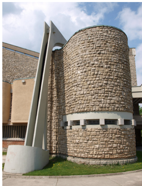
Ryc. 23. Kościół św. Józefa Robotnika w Kielcach – kaplica boczna i żelbetowa przypora; fot. autor
