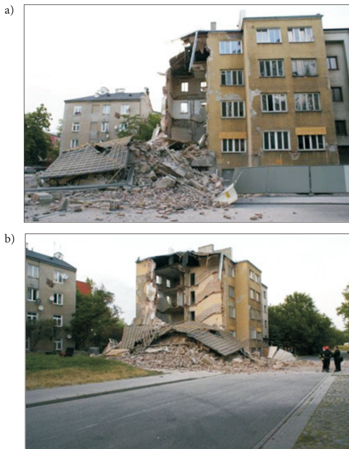
Rys. 2.3a, b. Budynek po zawaleniu jego części — przypadek nr 3 [2]
