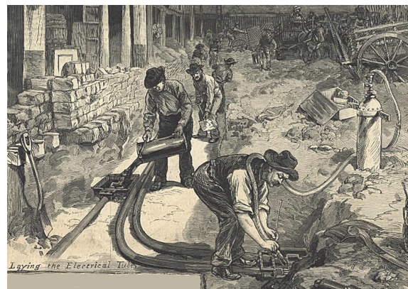
Rys. 9. Robotnicy Edisona układają pierwsze podziemne linie przesyłowe energii elektrycznej. Rysunek z Wikipedii https://en.wikipedia.org/wiki/War_of_the_currents#/media/File:Laying_the_electrical_Tubes_electric_lines_under_street_Edison_Pearl_Street_Utility_June_21_1882_Harpers_Weekly_-_detail.png
