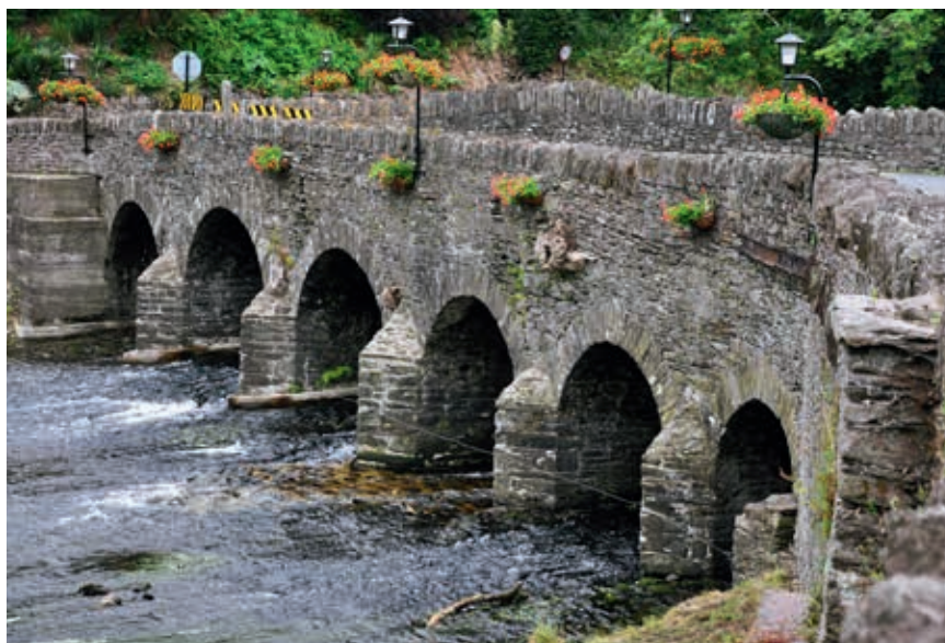
Ryc. 1. Kamienny most łukowy w Dripsey przez rzekę Dripsey (obiekt nr 35)
