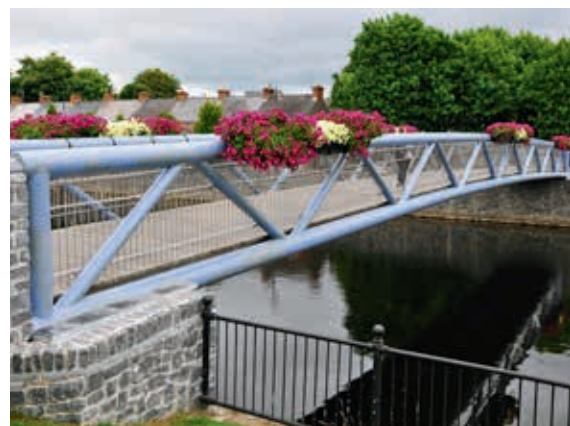
Ryc. 22. Stalowa kładka dla pieszych w Kilkenny (obiekt nr 45)
