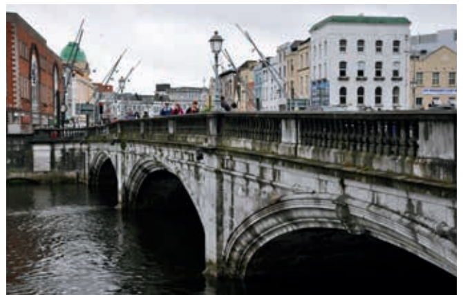
Ryc. 12. St. Patrick's Bridge w Corku (obiekt nr 41)
