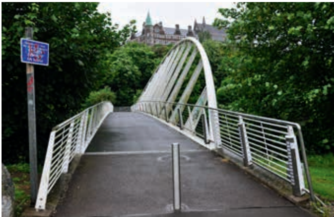
Ryc. 7. Łukowa kładka dla pieszych Mardyke Walk Bridge w Corku (obiekt nr 36)
