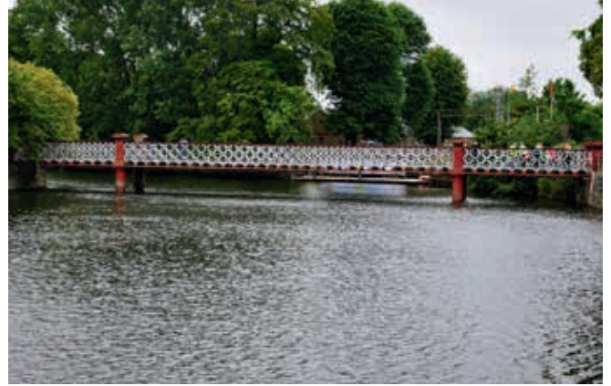
Ryc. 9. St. Vincent's Bridge w Corku (obiekt nr 38)
