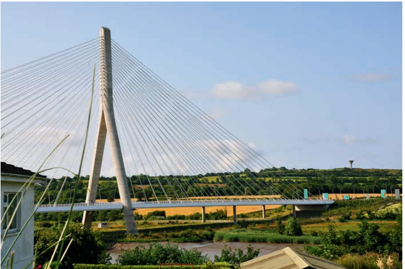
Ryc. 16. Most podwieszony River Suir Bridge w Waterford (obiekt nr 42)
