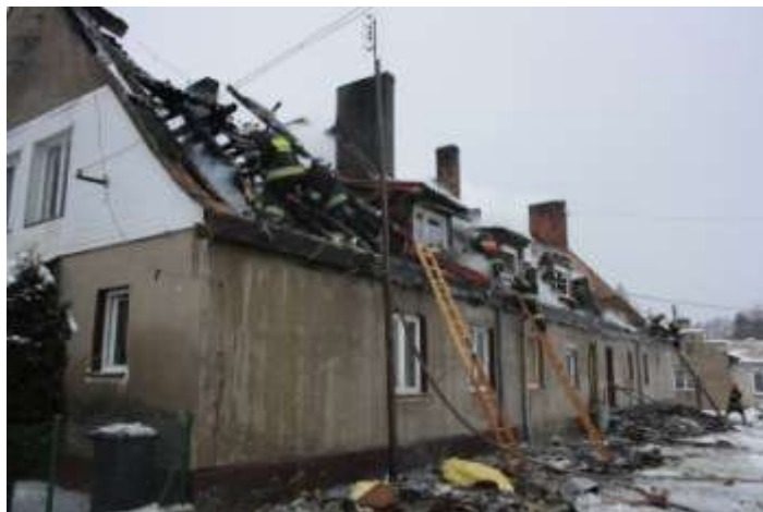
Fot. 4. Praca strażaków na dachu budynku (fot. K. Przybylski)
