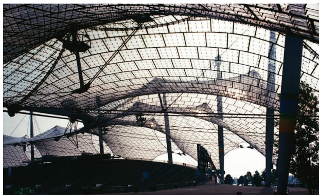
Il. 3. Stadion Olimpijski w Monachium. Dach (1972) (fot. T. Barucki)
