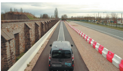
Fot. 3 i 4. „Droga elektryczna” umożliwiająca dynamiczne ładowanie e-pojazdów
