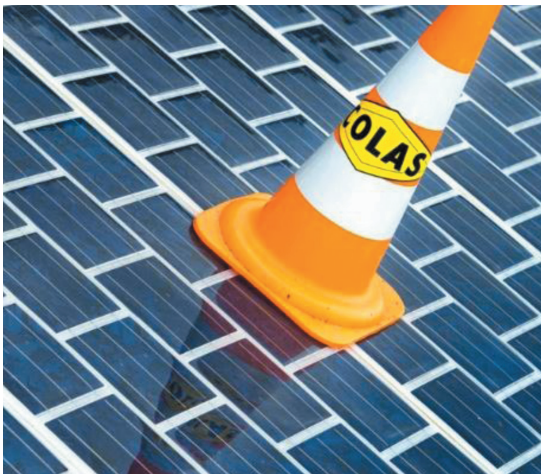
Fot. 1. Pionierska technologia "Wattway" francuskiej firmy Colas
