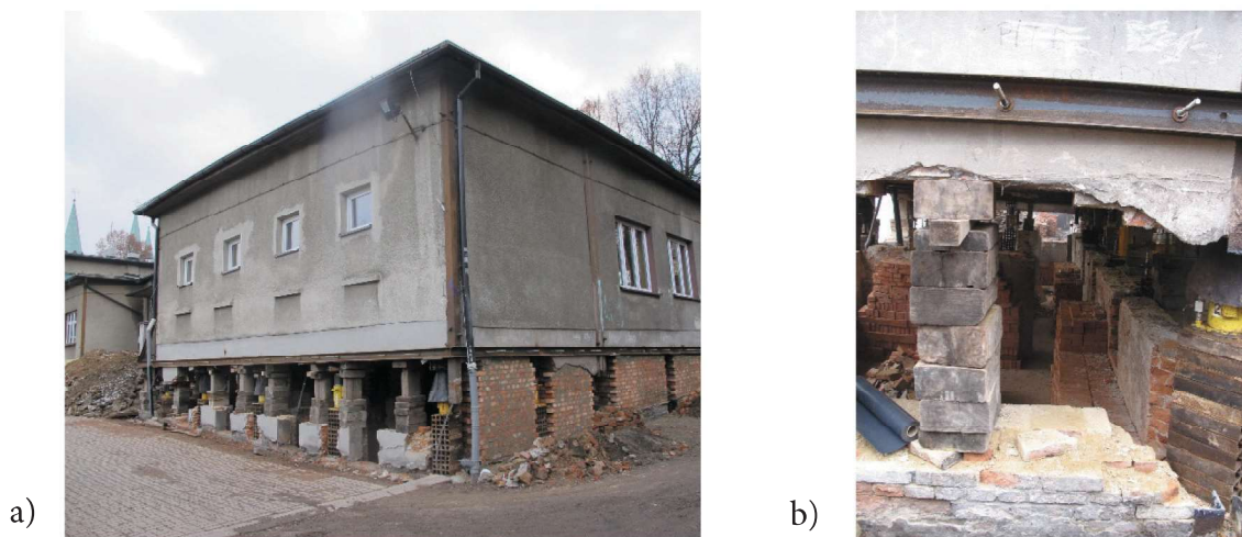
Rys. 2. Przykład zastosowania tymczasowych podpór przy usuwaniu wychylenia budynku: a) budynek spoczywający na tymczasowych podporach po usunięciu wychylenia w trakcie odtwarzania ścian, b) tymczasowa drewniana podpora zabudowana w nośnej ścianie obiektu (fotografie własne autora)
