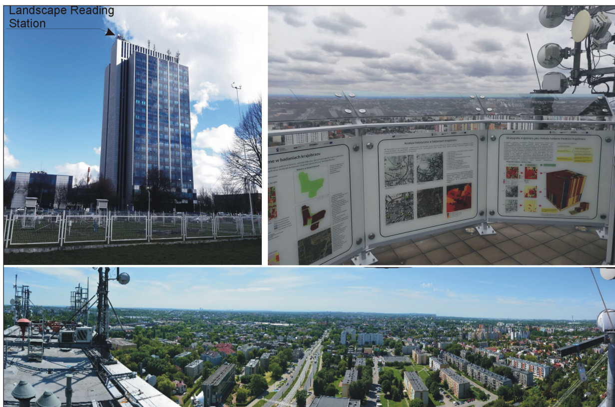
Ryc. 3. Stacja Czytania Krajobrazu UŚ. Widok na budynek Wydziału Nauk Przyrodniczych, Tablice umieszczone na Stacji, widok z dachu na dzielnicę Sosnowiec-Pogoń (fot. K. Pukowiec-Kurda).
