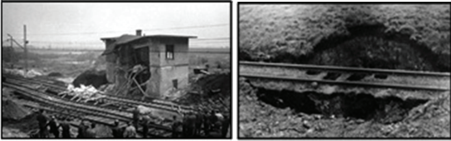
Rys. 3. Zapadlisko pod torami linii kolejowej Muchowiec-Zawiercie, powstałe w 1968 roku na posterunku odgałęźnym Mieszko KWK Mysłowice (fot. F.Grabowski w (Fajklewicz 2008))
