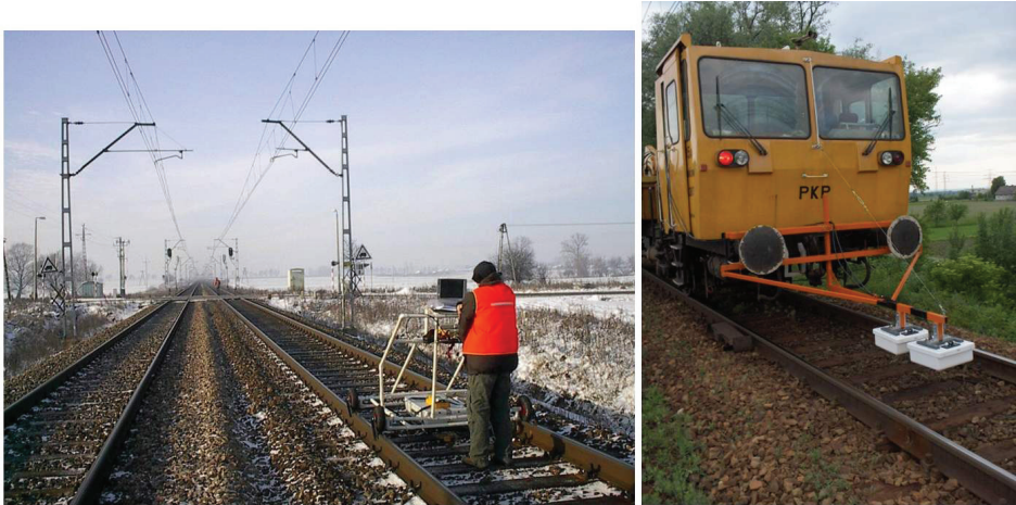
Rys. 7. Badania georadarowe podłoża linii kolejowej ( www.geopartner.pl )
