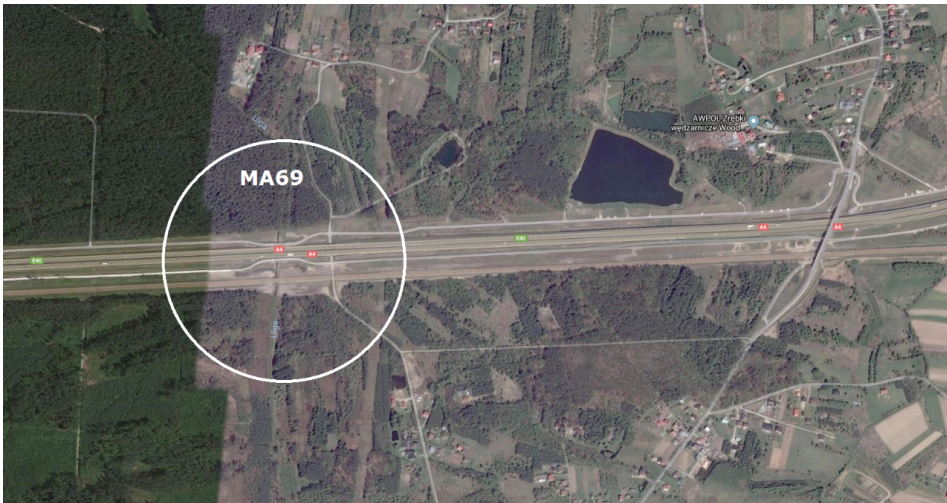
Rys. 4. Przejście dla zwierząt MA69
