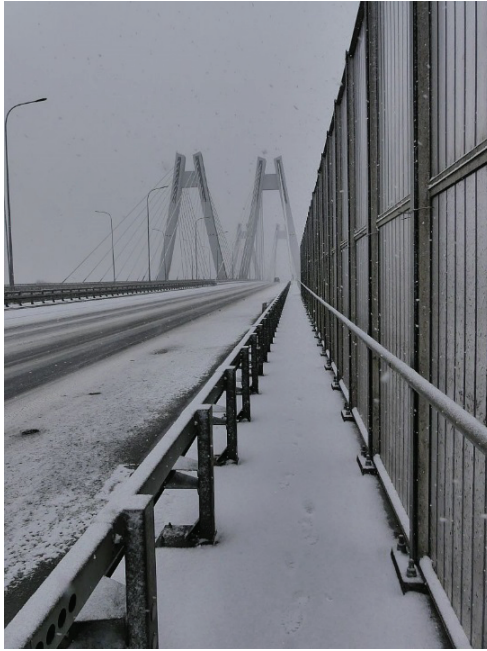
Fot. 1. Pas techniczny mostu [4]
