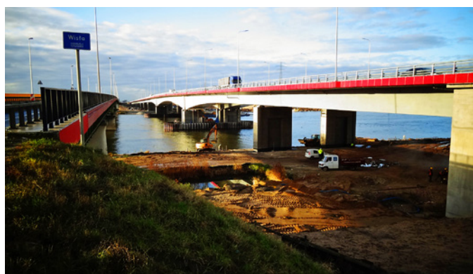
Ryc. 4. Most przez Wisłę w ciągu drogi S7, fot. K. Gwizdała
