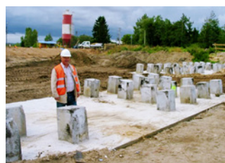
Ryc. 5. Estakada WE-1 w ciągu Południowej Obwodnicy Gdańska i wyniki próbnych obciążeń pala [5]
