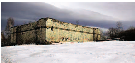
Ryc. 6. Widok Mauzoleum od tyłu – dawniej i dziś. Źródło: „Deutsche Bauzeitung (Kunstdruckteil)”, 1942, nr 4, s. 35; zdjęcie własne, 2011 Fig. 6. Back view of the Mausoleum – past and present. Source: “Deutsche Bauzeitung (Kunstdruckteil)”, 1942, no 4, p. 35; own photo, 2011
