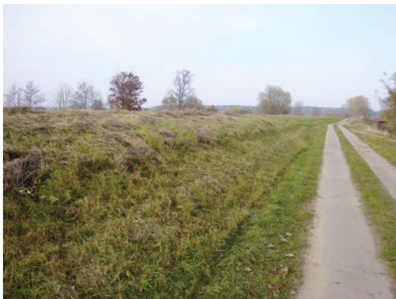
Fot. 1. Wały przeciwpowodziowe Prosny (ok. 700 m od ujścia do Warty)
