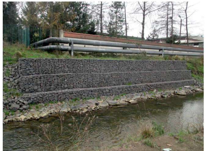
Fot. 8. Koryto rzeki Miedzianki – dodatkowe wzmocnienie brzegu Fot. 8. The bed of Miedzianka river – additional reinforcement of riverside
