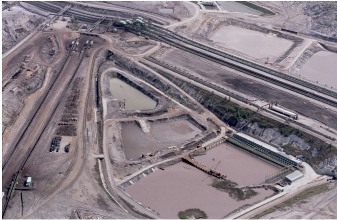
Fot. 9. Pompownia TII/4 - jedna z trzech głównych pompowni zlokalizowana w części wschodniej odkrywki KWB Turów o wydajności 272.8 m 3 /min
