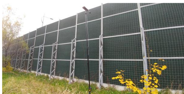
Rys. 10. Widok miejsca pomiarów w Tychach za ekranami akustycznymi
