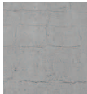
Rys. 8. Rysy powierzchniowe betonu nad zbrojeniem głównym płyty głównej mostu wskutek skurczu plastycznego i osiadania mieszanki betonowej
