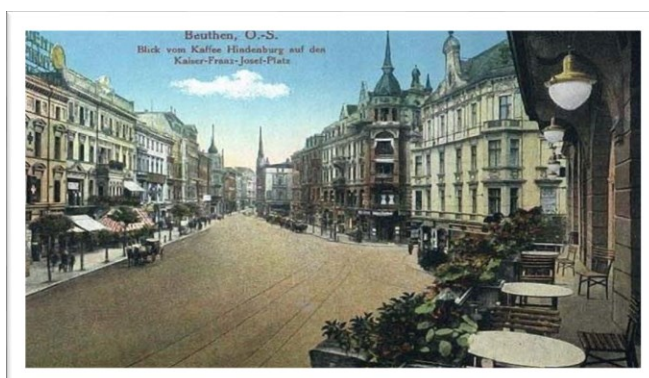
Rys. 1. Zabytkowe zabudowania Placu Kościuszki – Bytom
