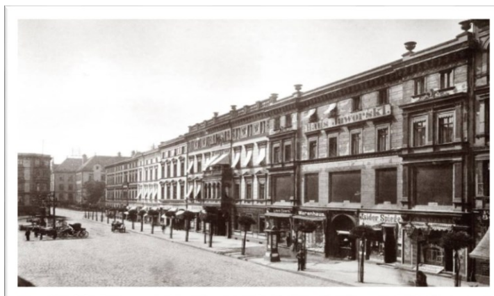
Rys. 2. Zabytkowe, wyburzone w latach 80-tych kamienice przy Placu Kościuszki – Bytom Źródło: Zdjęcie archiwalne.
