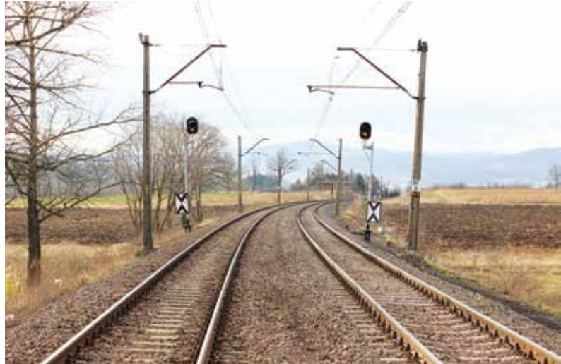
Nawierzchnia torów po naprawie średniej na szlaku Boguszów Gorce Zachód–Sędziszaw
