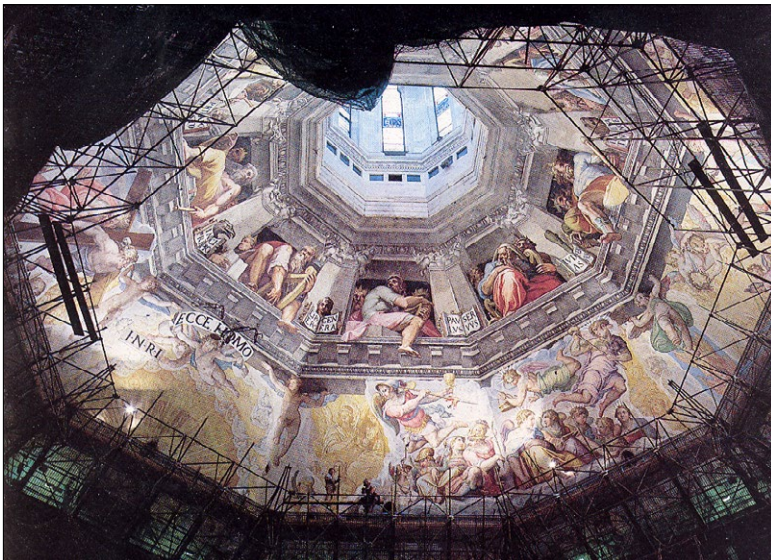
Ryc. 7. Kopuła Brunelleschiego z freskami Vasariego i Zuccariego w trakcie renowacji; widok ogólny i fragment z kilkucentymetrowym pęknięciem, po restauracji, źródło: C. Acidini Luchinat, R. Dalla Negra, La cupola di Santa Maria del Fiore. Architettura, pittura, restauro , Istituto Poligrafico del Stato, Libreria Cortina Milano, Rome 1995.
