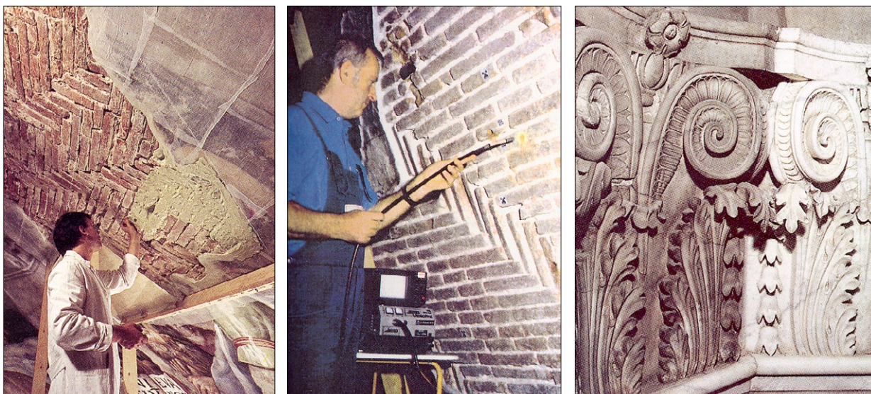
Ryc. 8. Lokalna translokacja fresków Vasarięgo i Zuccarięgo dla wzmocnienia podłoża i czyszczenia kamiennych detali latarni metodą ultradźwięków, źródło: C. Acidini Luchinat, R. Dalla Negra, La cupola di Santa Maria del Fiore. Architettura, pittura, restauro , Istituto Poligrafico del Stato, Libreria Cortina Milano, Rome 1995.
