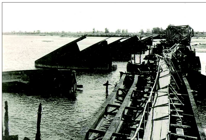
Fot. 4. Osiem ocalałych izbic mostu widocznych od strony Wyszogrodu na zdjęciu niemieckim z 1939 r. (zbiór autora)
