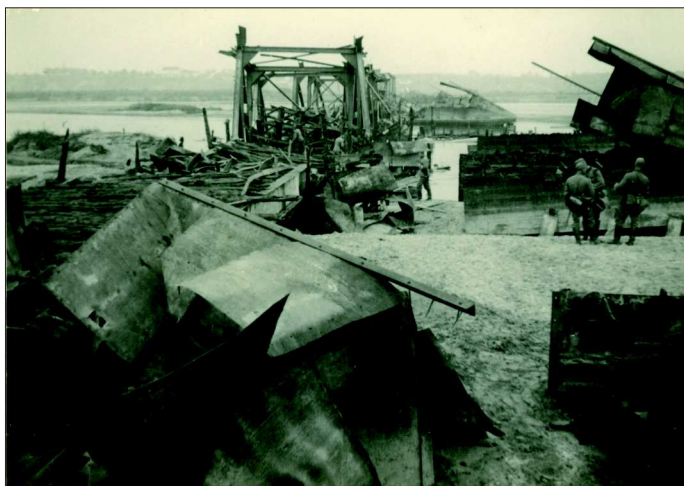
Fot. 9. Stalowe kratownice mostu w Wyszogrodzie z rozciętymi blachami węzłowymi przed demontażem elementów na zdjęciu niemieckiego sapera (zbiór autora)
