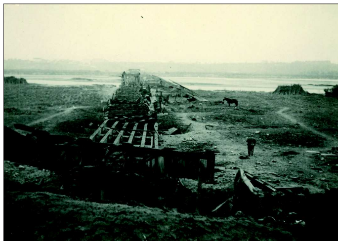
Fot. 11. Stalowe konstrukcje przęseł z belek dwuteowych przed demontażem na zdjęciu niemieckiego sapera (zbiór autora)
