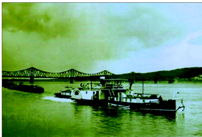
Fot. 12. Holownik Karl Blumwe (dawny Lubecki), którym wywożono elementy z rozbieranego mostu w Wyszogrodzie ( www.historia-wloclawka.pl/index.php/dzieje-holownika-lubeckiego 2013.08.30 g. 19.34)
