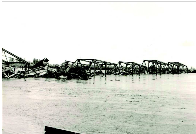
Fot. 3. Zwalone do rzeki przęsła mostu w Wyszogrodzie z kładką dla pieszych na zdjęciu niemieckim z 1939 r. (zbiór autora)
