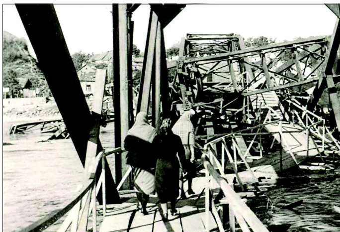
Fot. 5. Trzy kobiety idące po kładce w kierunku Wyszogrodu wewnątrz zwałonego do rzeki stalowego kratownicowego przęsła na zdjęciu niemieckim z 1939 r. (zbiór autora)
