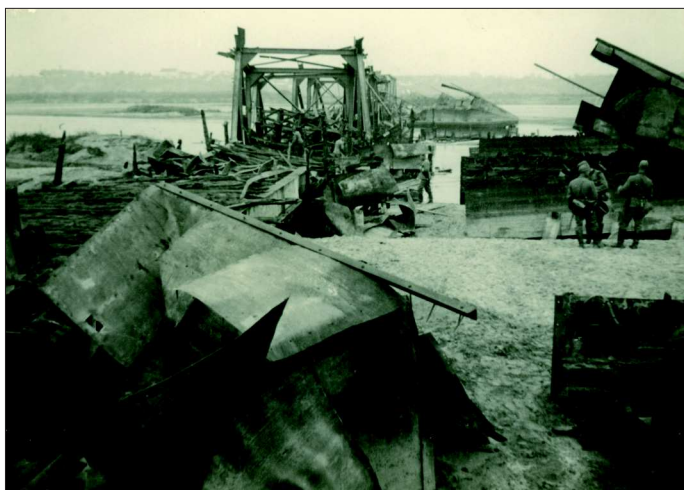
Fot. 10. Demontaż stalowych konstrukcji mostu na zdjęciu niemieckiego sapera (zbiór autora)
