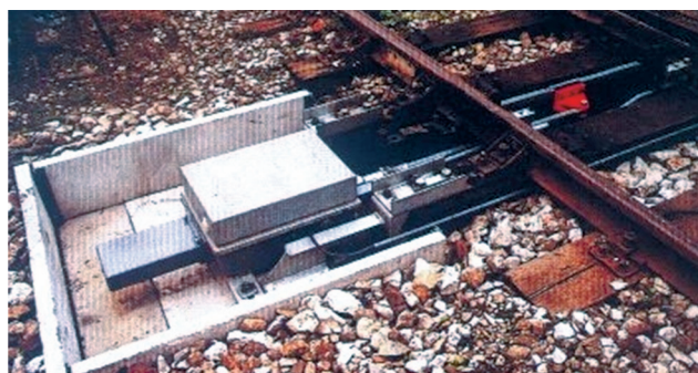
Rys. 3. Sposób zamocowania napędu zwrotnicowego S700 KM do rozjazdu [7]
