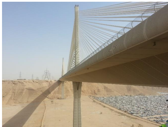
Rys. 5. Widok przykładowego mostu podwieszanego z wdrożonym systemem monitoringu fizycznego – fot. Cementys (zamieszczono za zgodą)
