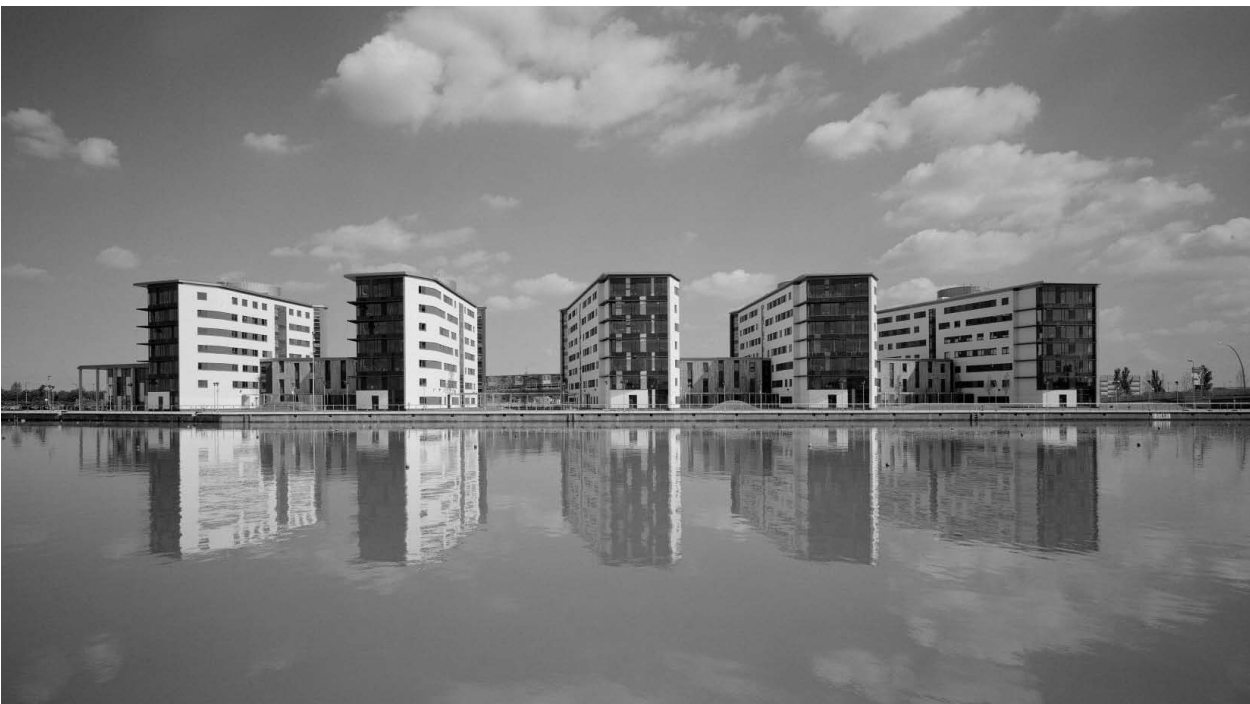
Ryc. 2. Zabudowa mieszkaniowa w dzielnicy Docklands w Londynie wzniesiona przed Igrzyskami Olimpijskimi 2012, proj.: Fraser Brown MacKenna Architects; fot.: James Morris
