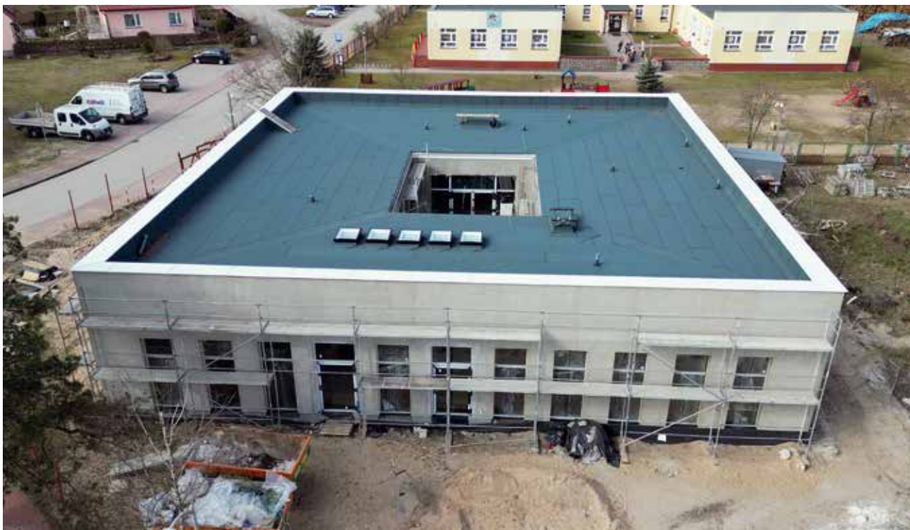
Rys. 9. Żłobek w trakcie budowy – stan z kwietnia 2023; źródło: autor
