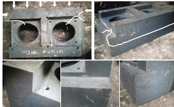
Rys. 7. Zdjęcia dolnej płyty stołowej, wykonanej ze stali WNLV, stosowanej do kucia (na biało zaznaczono linie pęknięć oraz miejsca ich występowania)
