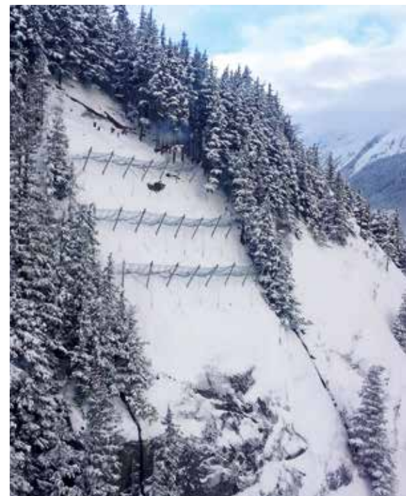
Bariera przeciwlavinowa, system Spider, Chiny, Mile Terrace
