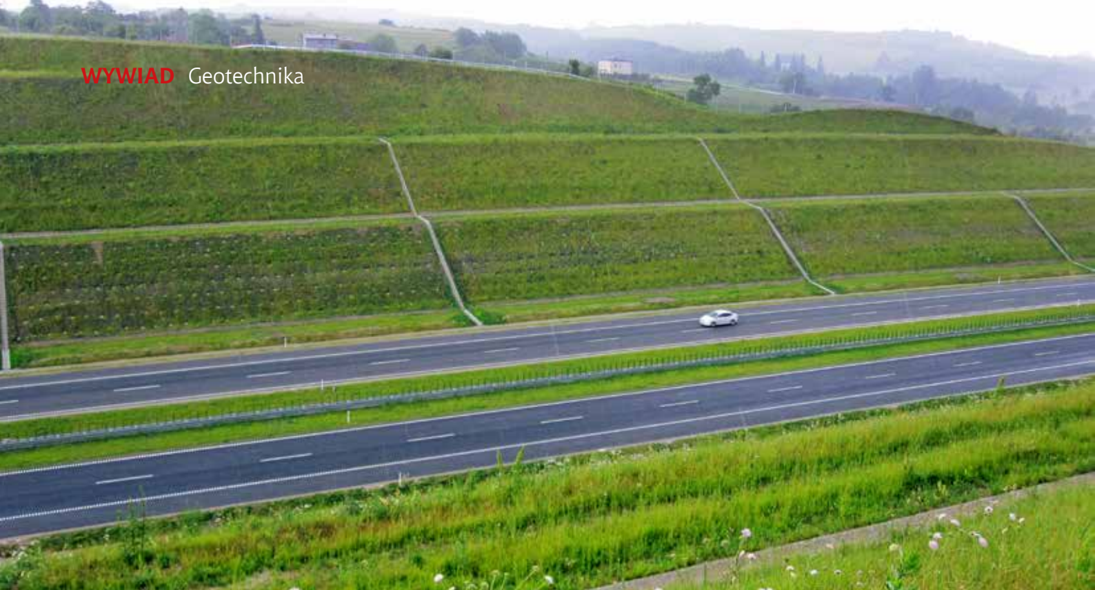
Zabezpieczenie skarpy na autostradzie A1 Piekary Śląskie – Maciejów
