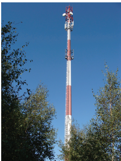
Fot. 1. Widok ogólny wieży
