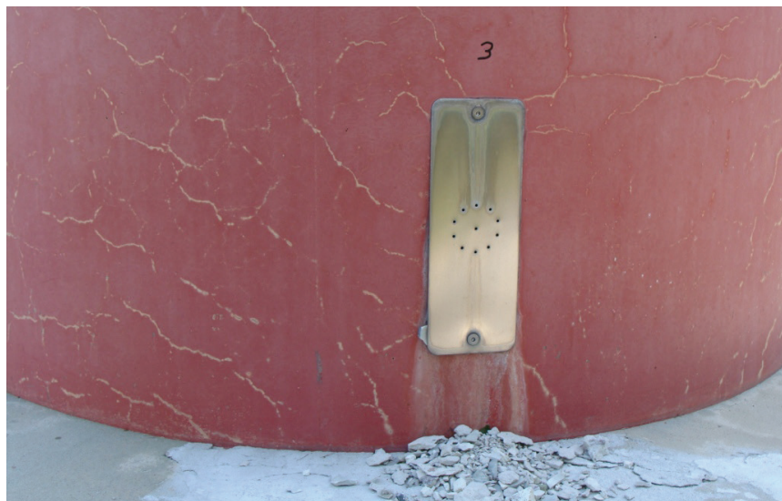
Fot. 4. Mikrorysy w dolnej części wieży
