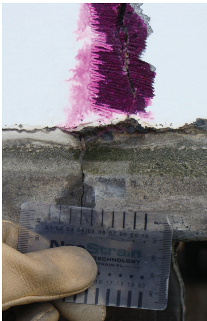
Fot. 5. Badanie głębokości karbonatacji betonu
