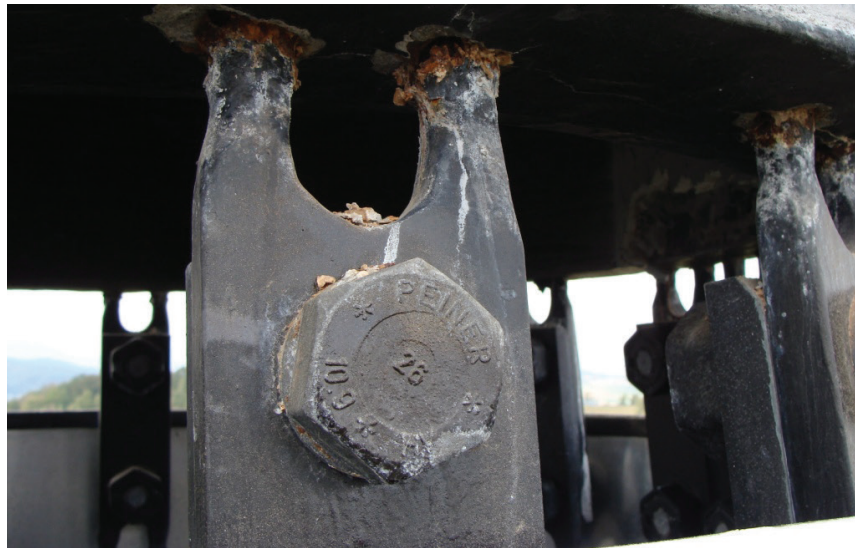
Fot. 2. Szczegół złącza prefabrykatów
