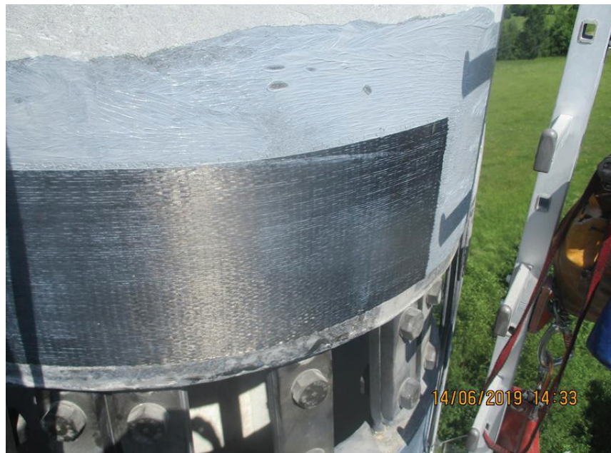
Fot. 6. Zabezpieczenie zarysowanej strefy elementów wieży za pomocą przyklejanych mat z włókna węglowego
