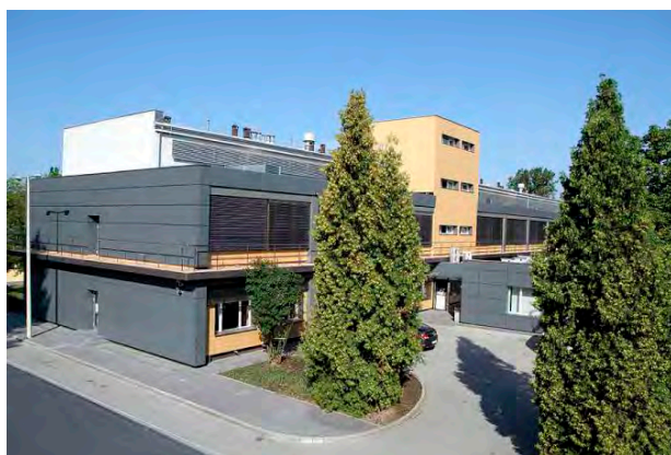
Fot. 3. Budynek po modernizacji pod nazwą Centrum Radiochemii i Chemii Jądrowej [5] (fot. IChTJ) Photo 3. The building after modernization under the name Radiochemistry Center and Nuclear Chemistry [5] (photo: IChTJ)
