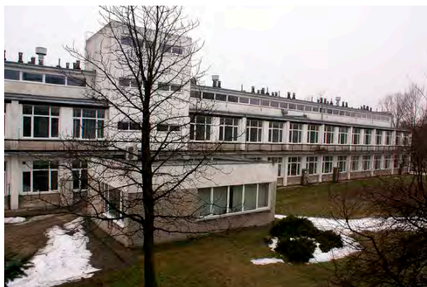
Fot. 2. Budynek przed modernizacją [5] (fot. IChTJ) Photo 2. The building before modernization [5] (photo: IChTJ)
