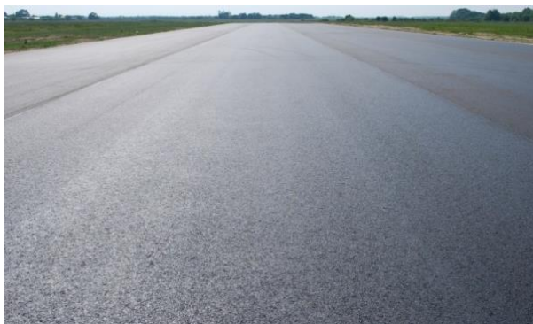
Rys. 2. Nawierzchnia podatna z betonu asfaltowego
