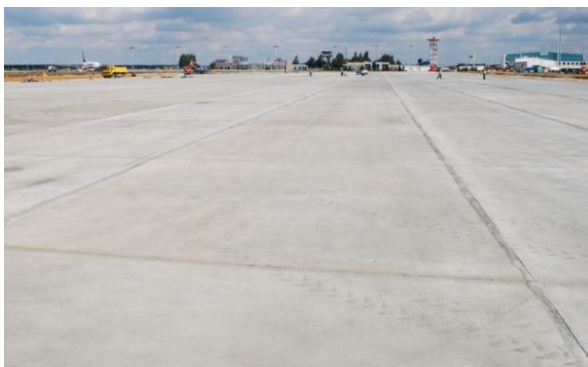
Rys. 1. Nawierzchnia sztywna z betonu cementowego
