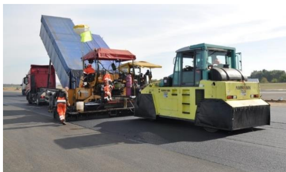
Rys. 5. Układanie mieszanki mineralno-asfaltowej (nawierzchnia z betonu asfaltowego)
