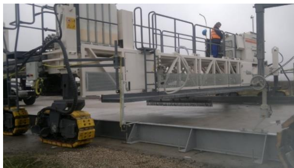
Rys. 4. Nadawanie faktury na nawierzchni z betonu cementowego
