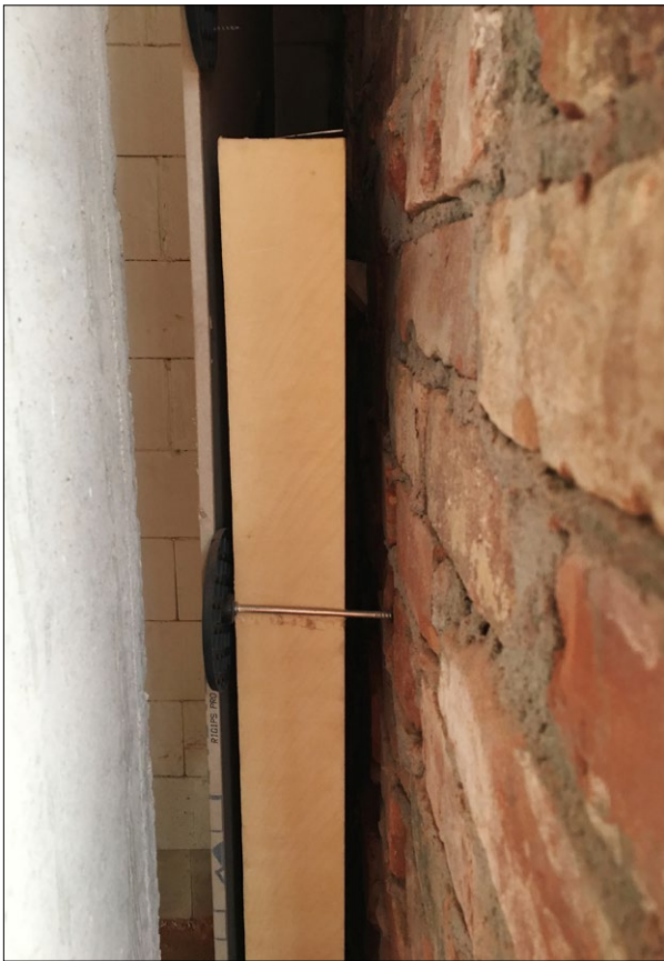
Fig. 9. Thermal wall insulation installed from the inside; photo by P. Marciniak. Ryc. 9. Izolacja termiczna ścian mocowana od wewnątrz; fot. P. Marciniak.
