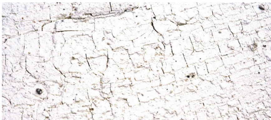
Rys. 4. Spękania skonsolidowanej warstwy osadów wywołane długotrwałą suszą. Składowisko byłych Krakowskich Zakładów Sodowych (fot. M. Gliniak) Fig. 4. Cracks in the consolidated layer of the sediments caused by the long drought. Dumping grounds of former Sodium Processing Plant in Kraków (photo by M. Gliniak)
