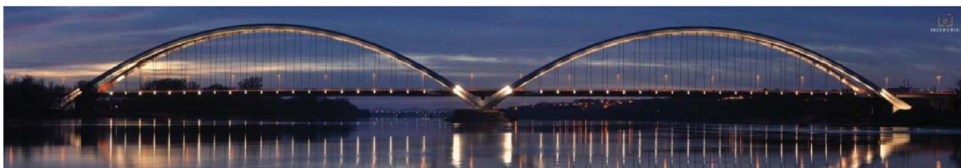
Rys. 13. Przęsta podwieszona mostu przez Wisłę w Toruniu (fot. M. Nasieniewski)
