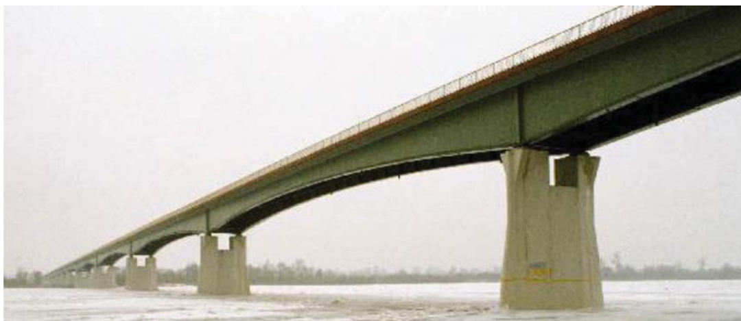
Rys. 10. Most przez Wisłę w Wyszogrodzie 1999. Wykonanie Mostostal Kraków-Dromex (foto mostostalzabrze.pl)
