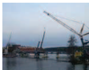
Rys. 10. Montaż nowego pylonu
