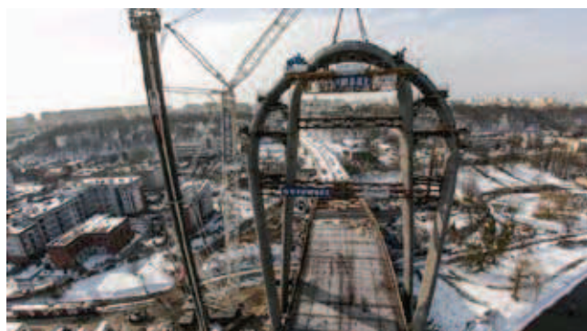
Rys. 6. Widok ogólny konstrukcji mostu
