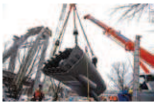
Rys. 8. Montaż prefabrykowanego segmentu zwieńczającego część pylonu w kształcie litery \Omega
