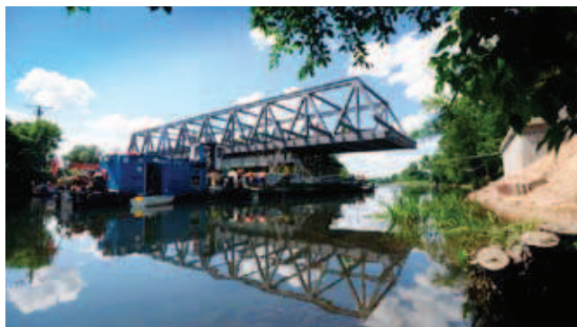
Rys. 3. Montaż konstrukcji poprzez nasuwanie
