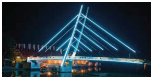
Rys. 9. Iluminacja wykonanej kładki
