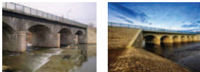
Rys. 5. Po lewej: most przed remontem; po prawej: most po oddaniu do użytkowania
