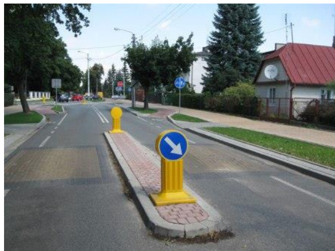
Rys. 5. Wyspowy próg spowalniający źródło: [11]
