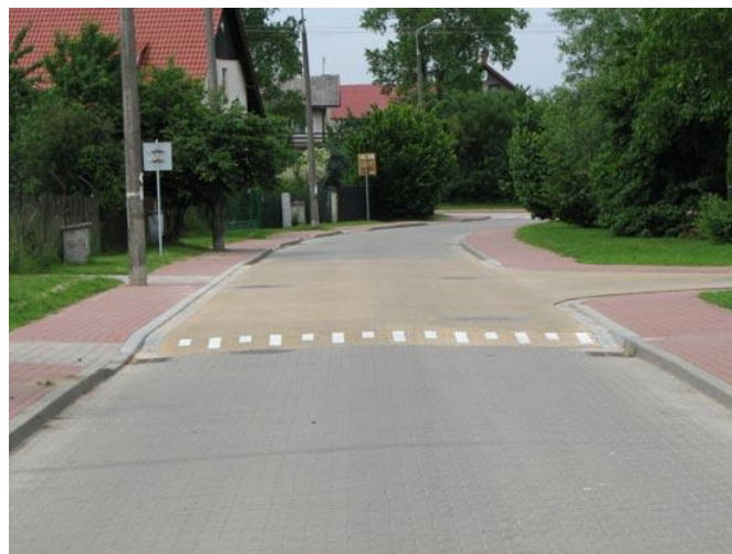
Rys. 4. Próg zwalniający typu poduszka źródło: [12]
