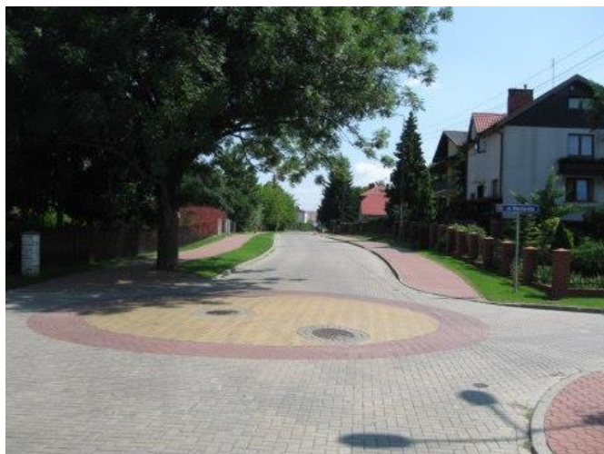
Rys. 3. Próg zwalniający typu pinezka źródło: [11]
