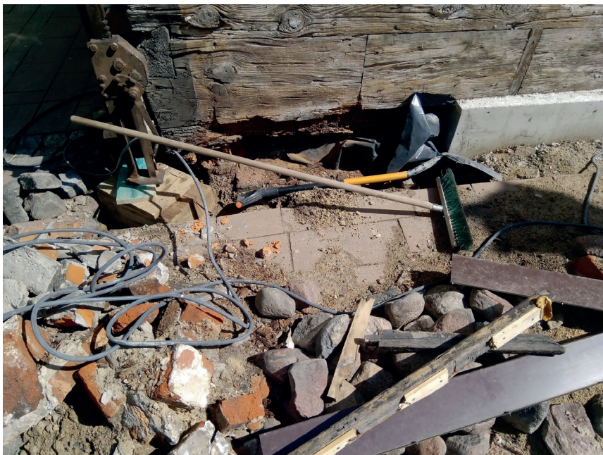
Rys. 4. Prace przy naprawie podwaliny usytuowanej poniżej poziomu wywyższonej drogi; źródło: fot. aut.
