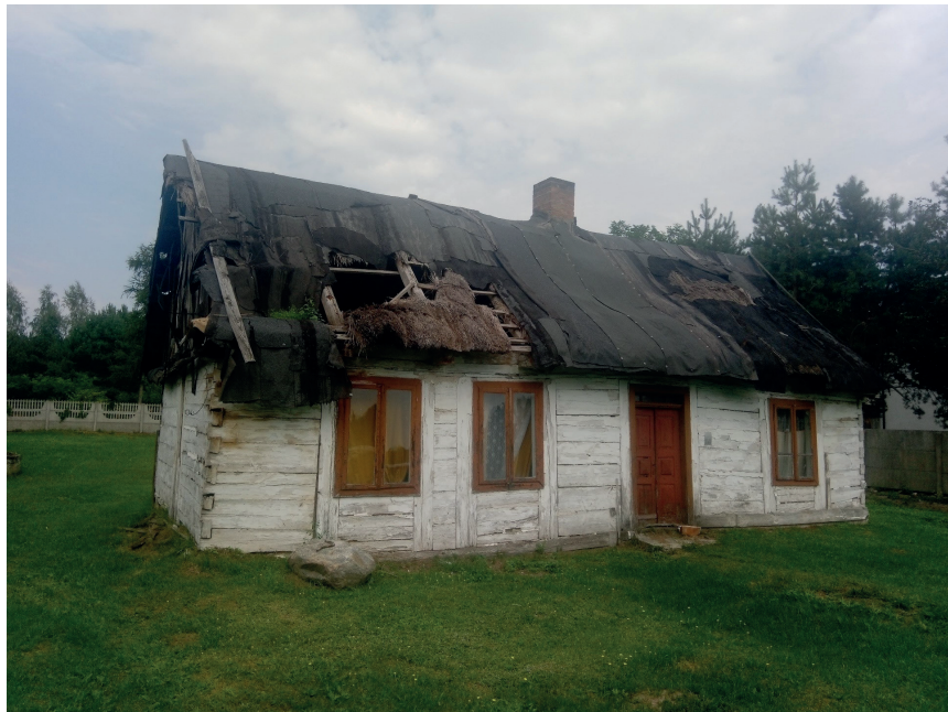
Ryc. 2. Budynek drewniany podlegający ocenie w aspekcie jego stanu zachowania i utraty walorów zabytkowych; źródło: fot. aut.
