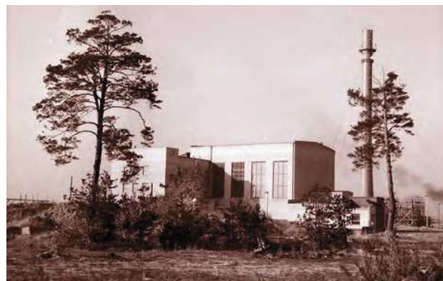
Fot. 2. Budynek reaktora EWA od tyłu
