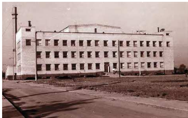
Fot. 1. Budynek reaktora EWA od frontu
