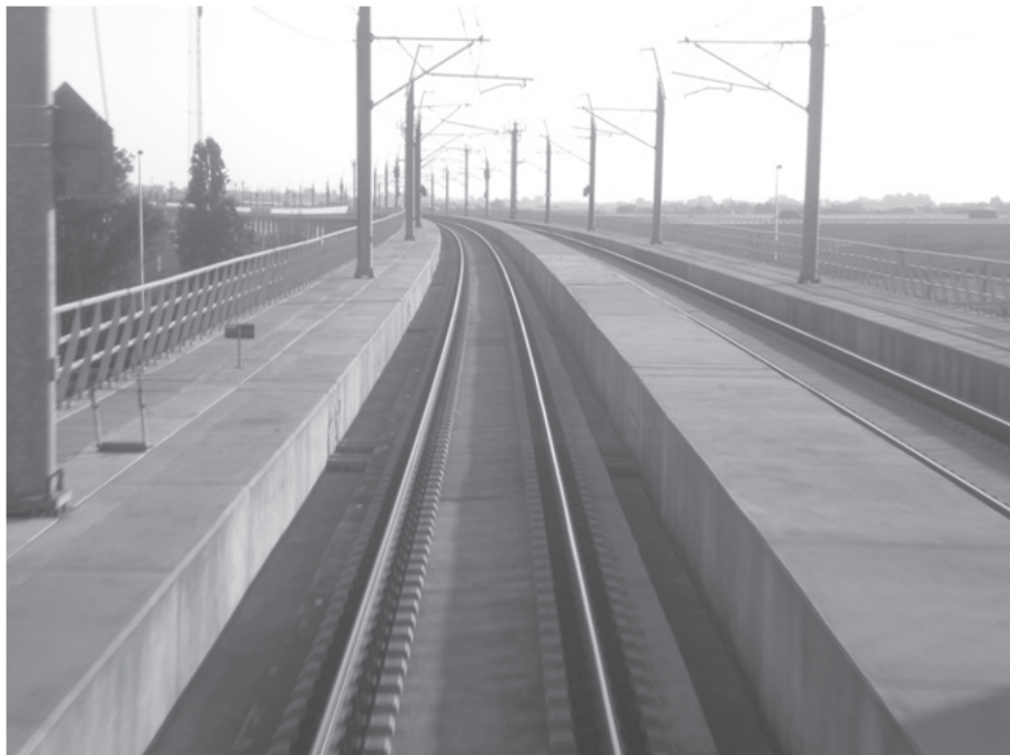
Rys. 1. Widok toru z nawierzchnią niekonwencjonalną na linii dużych prędkości w Holandii
