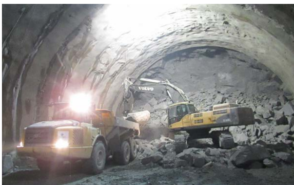
Fig. 5. Loading and transportation of excavated material from the tunnel [source: 11] Rys. 5. Załadunek i wywóz urobku z tunelu [źródło: 11]
