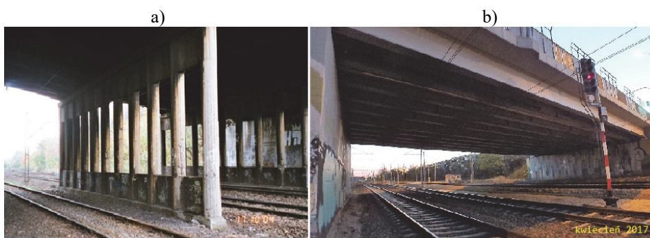
Rys. 4. Wiadukty w ciągu ul. Powązkowskiej - porównanie konstrukcji; a) stara – konstrukcja z 1946r. (stan z 2004r.); b) nowa – konstrukcja z 2012r. (stan z 2017r.)
