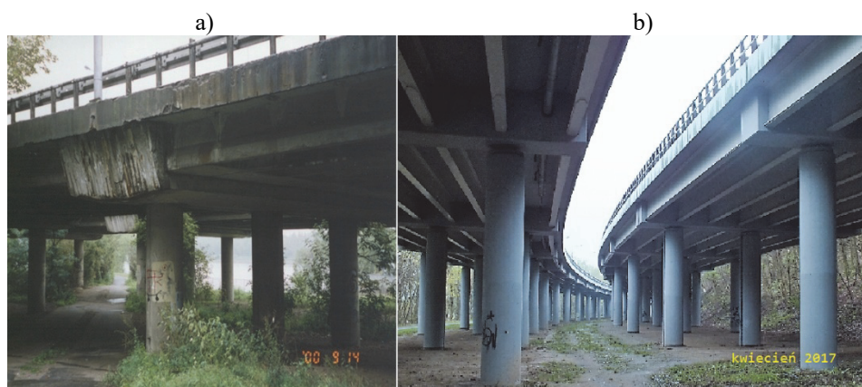
Rys. 10. Estakady Bielańskie (Wisłostrada) – porównanie konstrukcji; a) stara – z 1974r. (stan z 2000r.); b) nowa – zespolona z 2009r. (stan z 2017r.)
