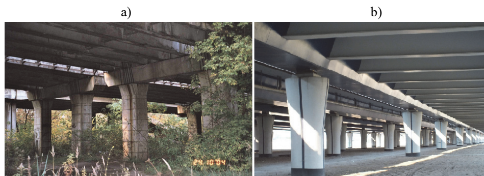
Rys. 20. Obiekty Trasy Toruńskiej nad terenami byłej FSO i torami PKP; a) wiadukty środkowe z 1976r. (stan z 2004r.); b) dzisiejsze konstrukcje – na pierwszym planie widoczny obiekt 25T (stan z 2017r.)
