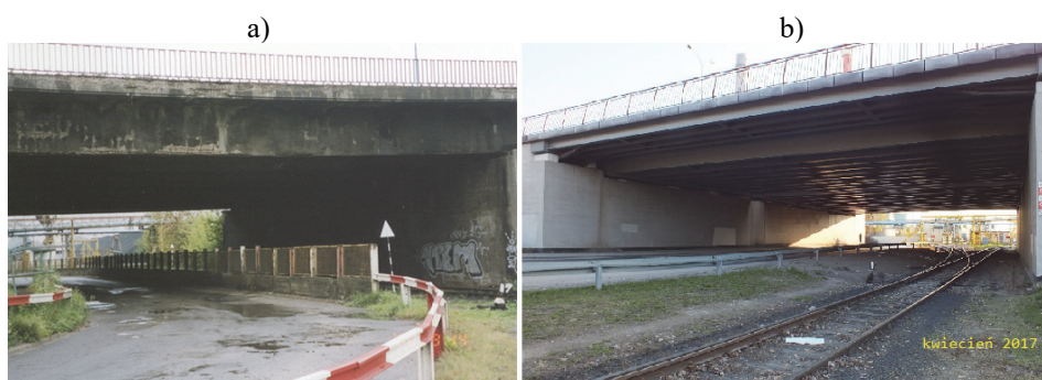
Rys. 12. Wiadukt w ciągu ul. Modlińskiej nad torami boczny do EC Żerań; a) stary - konstrukcja z 1957r. (stan z 2000r.); b) nowy - konstrukcja z 2011r. (stan z 2017r.)
