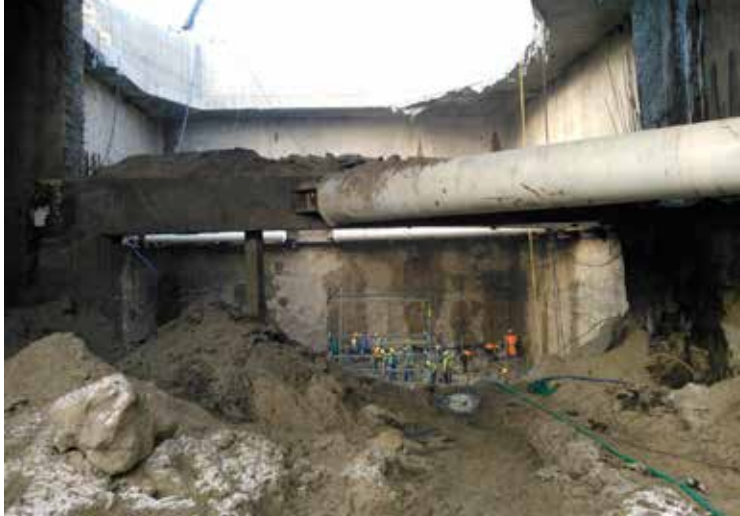
Fot. 2. Ściany szczelinowe w obrębie komory startowej TBM
