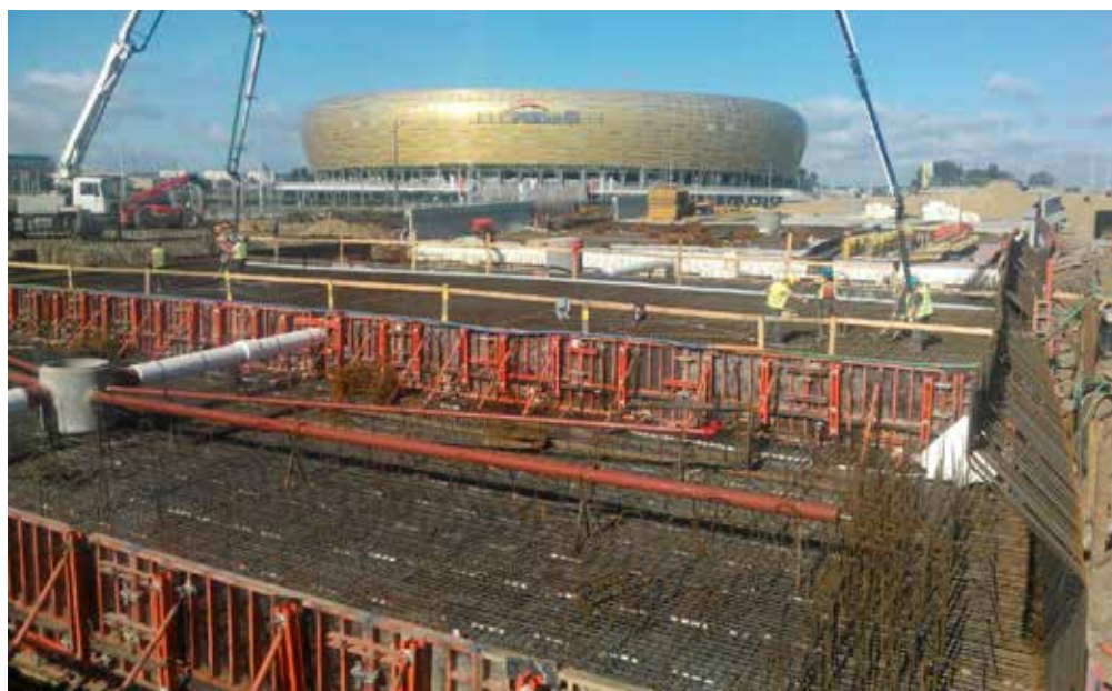
Fot. 3. Betonowanie płyty fundamentowej wanny żelbetowej
