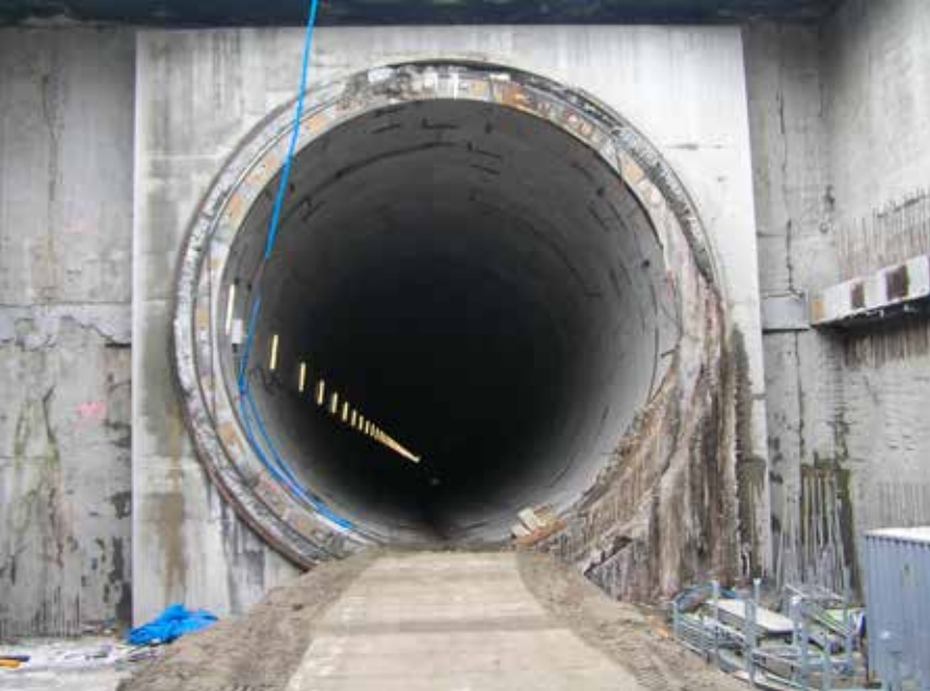
Fot. 5. Widok ściany okularowej w szybie startowym
