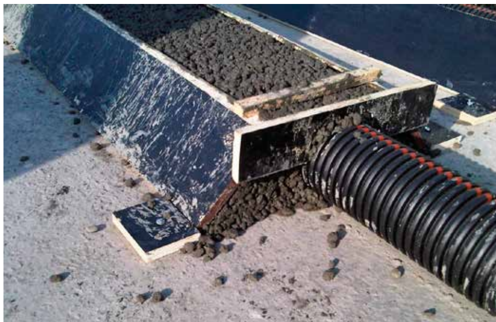
Fot. 9. Beton o otwartej strukturze w systemie drenażowym tunelu
