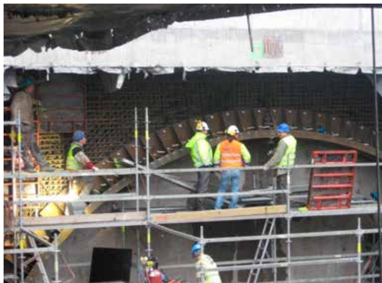
Fot. 7. Widok ściany okularowej w szybie wyjściowym (dolne zdjęcie)
