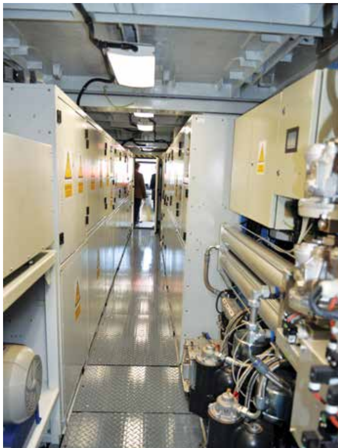
Przedział maszynowy lokomotywy elektrycznej typu 207E
