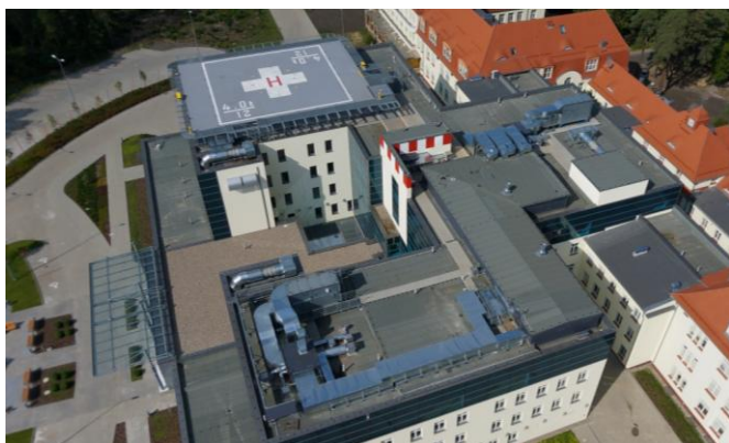
Fot. 3. Lądowisko wyniesione na dachu Szpitala Specjalistycznego w Szczecinie Zdunowie.
