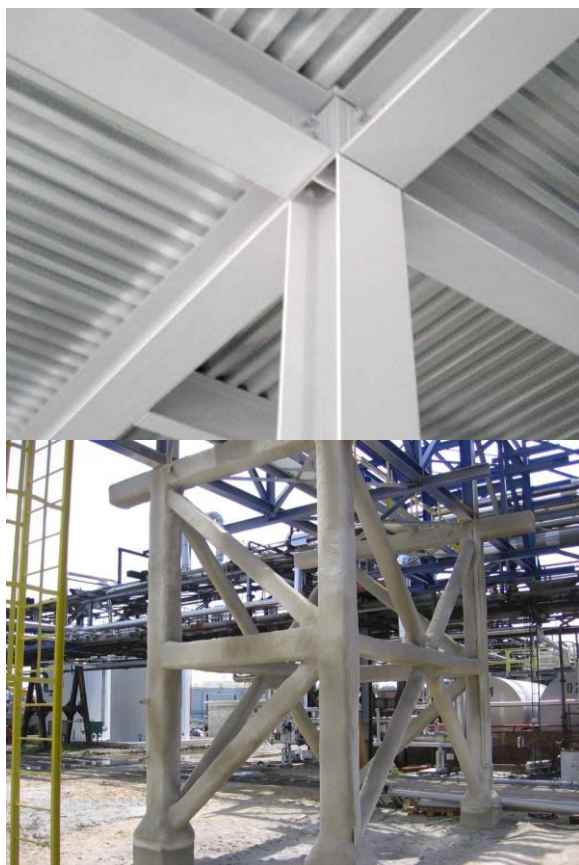
Fot. 5. Przykład zabezpieczonych ogniochronnie konstrukcji stalowych. Po lewej farby pęczniące, po prawej masa natryskowa (autor: archiwum ITB)
