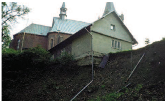
Rys. 4. Przykład utraty stateczności skarpy (zdjęcie autora)
