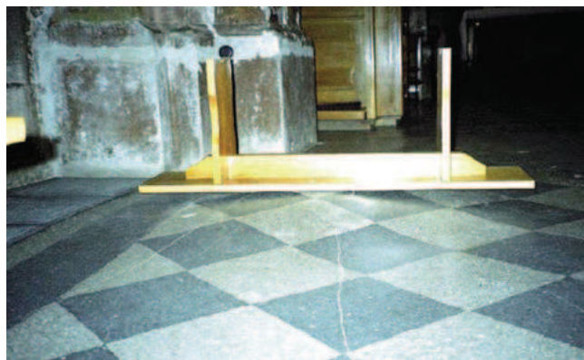
Rys. 3. Przykład wybruszenia posadzki (zdjęcie autora)
