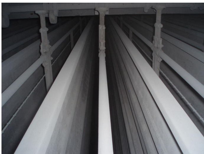
Rys. 2.5. Płaski układ elektrod (elektroda zbiorcza typu SIGMA i elektroda ulotowa ramowa taśmowa) [8]
