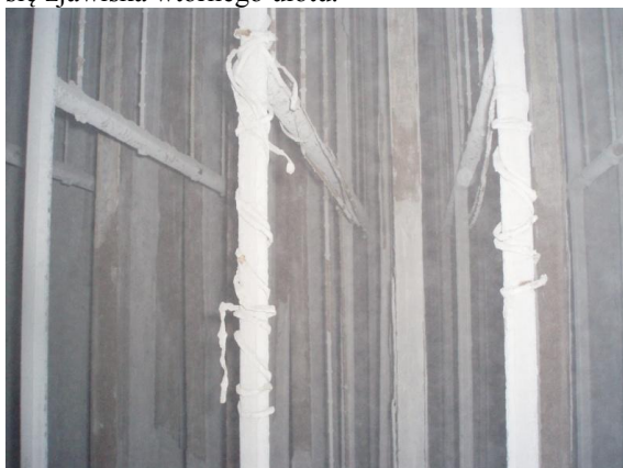
Rys. 2.9. Elektroda ulotowa w postaci taśmy kolczastej zamocowanej w ramie – efekt zrywania [8]
