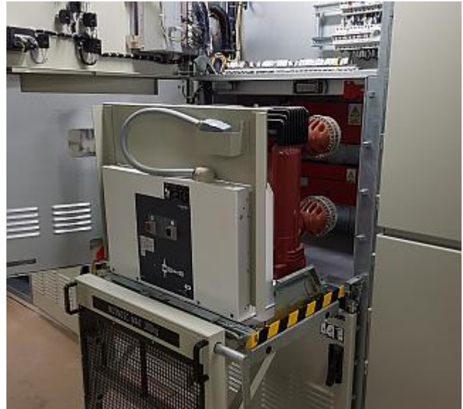
Rys. 1. Wyłącznik próżniowy średniego napięcia, serii HVX z członem wysuwym firmy Schneider Electric [fot. opracowanie własne autorów artykułu]
