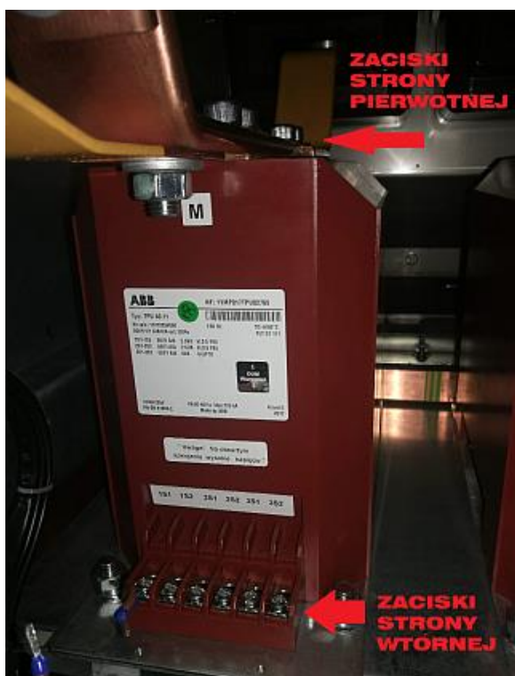
Rys. 5. Przekładnik prądowy wewnętrzny serii TPU 40.11, firmy ABB [fot. opracowanie własne autorów artykułu]
