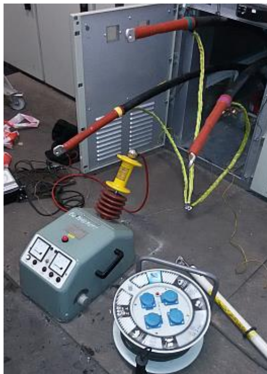
Rys. 8. Wykonywanie próby napięciowej linii kablowej za pomocą aparatu ABK-45/55A „Kenetron” [fot. opracowanie własne autorów artykułu]
