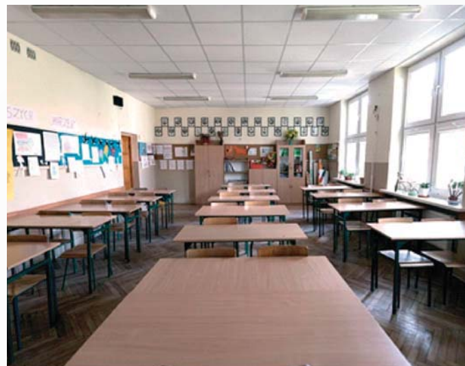
Fot. Sala lekcyjna nr 3 z zainstalowanym dźwiękochłonnym sufitem podwieszanym (fot. autora) Photo. Classroom 3 with suspended ceiling
